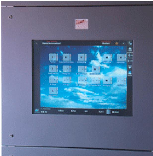
Leistungsfähige, flexible und ausbaufähige Steuerung von beliebigen Aktoren wie Licht, Rolläden, Markisen, Jalousien, Sonnenschutzanlagen usw. auf PC-Basis. Die Bedienung der Aktoren ist durch ein benutzerfreundliches 15" TFT-Display mit Touchscreen ausgeführt.
